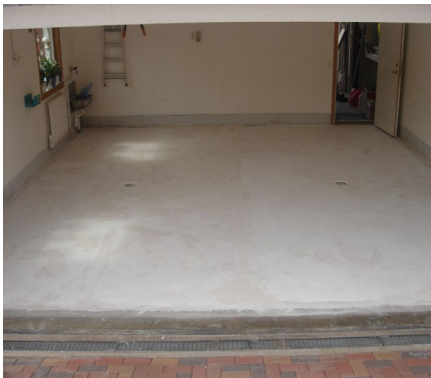
Före - Obehandlat Betonggolv
