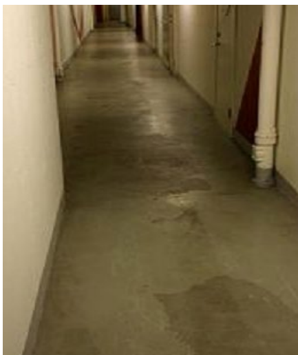
Före - Tidigare Målat med Epoxifärg
